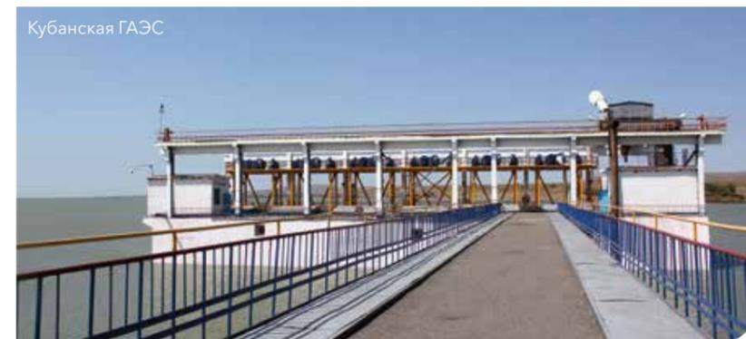
Проект масштабной модернизации старейшей ГАЭС России – Кубанской – одобрен Главгосэкспертизой. Использование высокоэффективного оборудования позволит увеличить мощность ГАЭС в турбинном режиме на 19%, в насосном – на 30%, среднегодовая выработка электроэнергии возрастет более чем на 50%.
