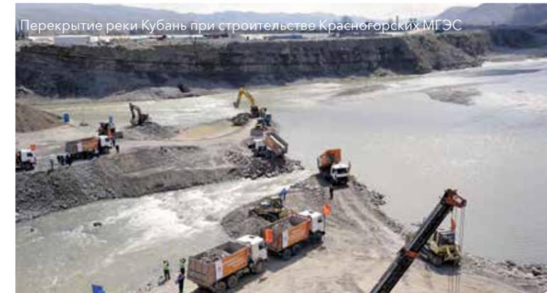
На строительстве Красногорских МГЭС-1 и 2 в Карачаево-Черкесской Республике перекрыто русло реки Кубань. Течение реки через уже построенный водосброс ГЭС дало возможность развернуть строительство здания с машинным залом второй малой гидроэлектростанции.
